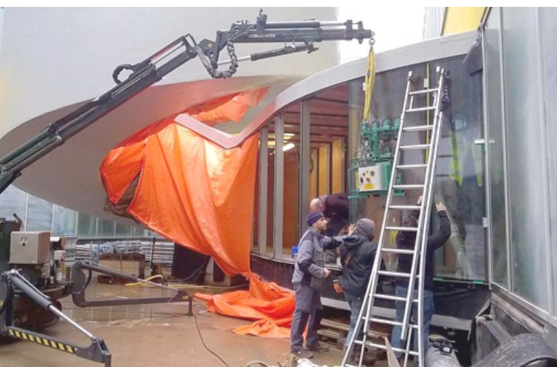
Plaatsing van de beglazing met de minikraan van DDQglas
