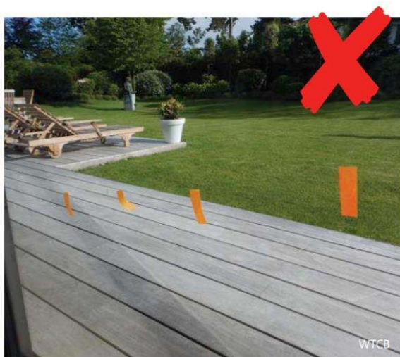
4 | Afwijkingen mogen niet op de beglazing gemarkeerd worden alvorens deze te bestuderen.
