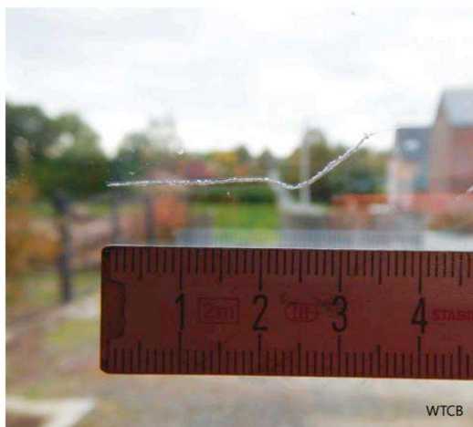
1 | Lineaire fout (niet toelaatbaar).
